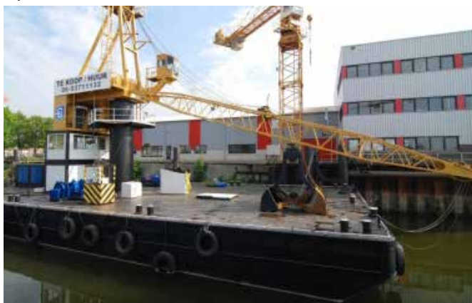
Een overslagponton uitgerust met een vaste kraan
