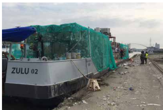
Afvoer van afvalmaterialen, bv. karton in balen
